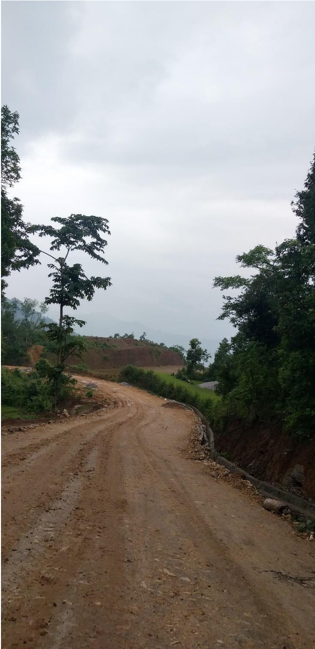
कालोपत्रे सडकको लागि दिला सतिघाट सडक ग्राभेल तथा नाली निर्माण
