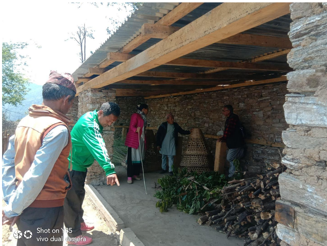
षडानन्द न.पा. १३ बोयामा सुधारिएको गोठ खोरहरु निर्माण
