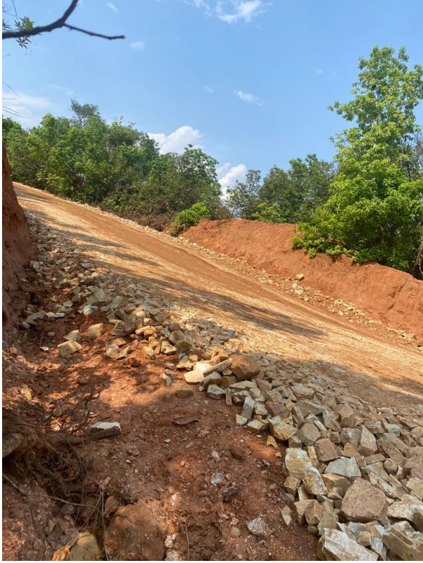
दिङ्ला सतिघाट सडक खण्ड अन्तर्गत सालघरी क्षेत्रमा सव वेस निर्माण सम्पन्न
