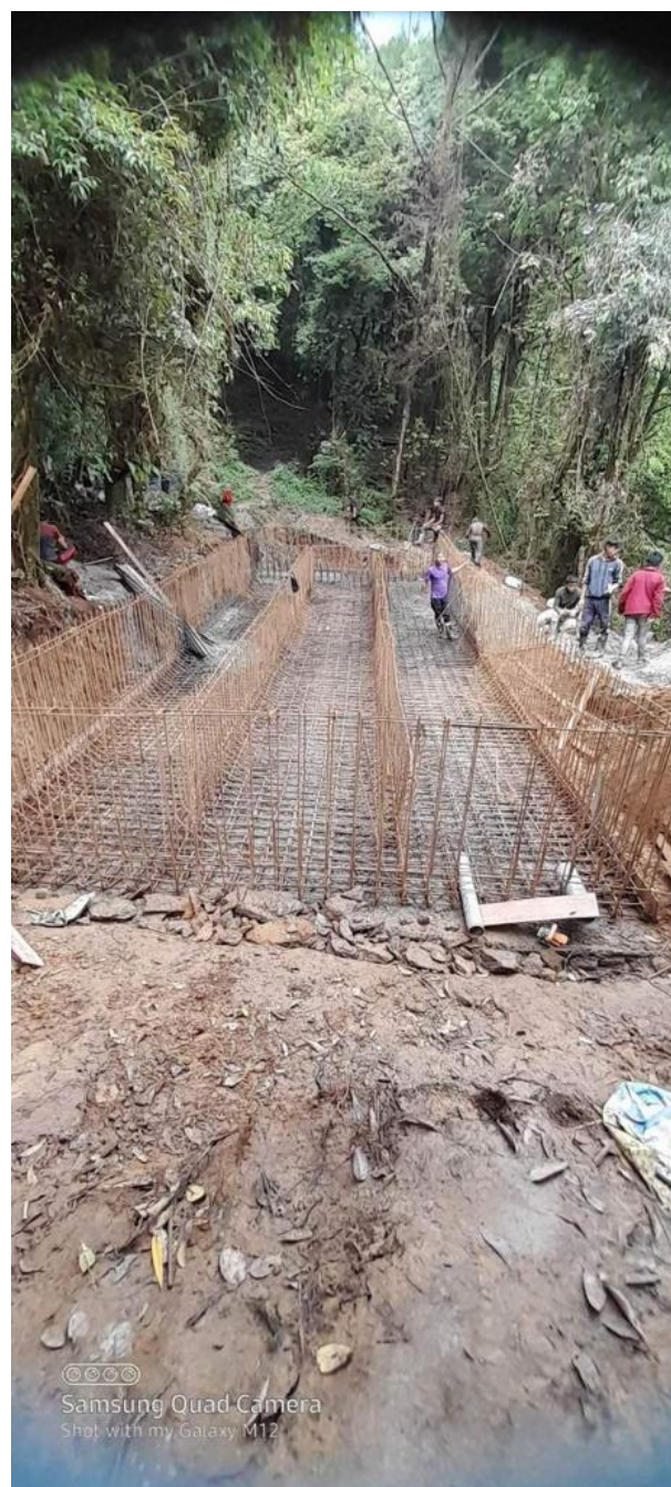
ष.न.पा. — ९ किमालुङ्ग स्थित लमु खोला खानेपानी आयोजनाको सेडिमेन्टेसन ट्याँकी निर्माण हुँदै
