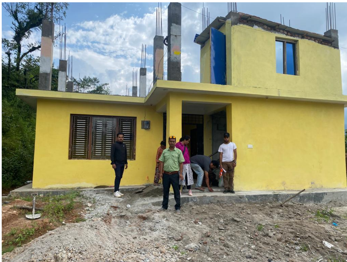
षडानन्द नगरपालिका ४ नं वडा कार्यालय भवन निर्माण सम्पन्न
