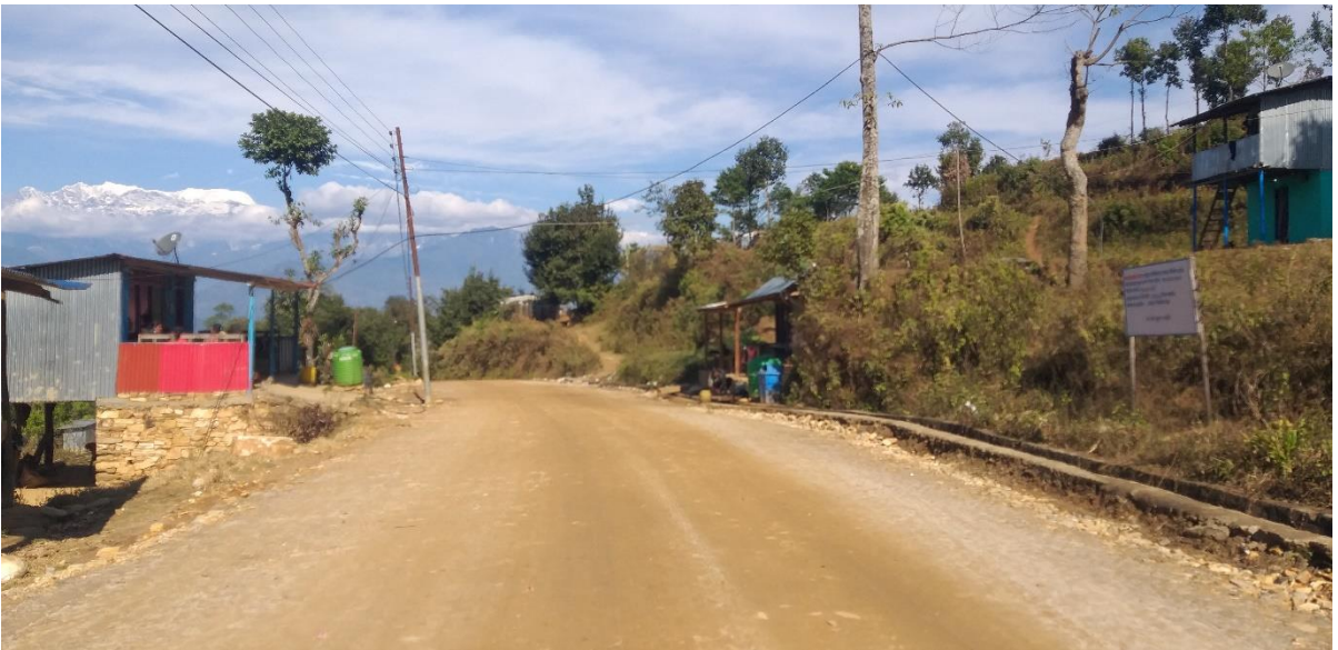
दिङ्ला सतिघाट सडक कालो पत्रे (पक्की) सडक निर्माणको लागि सब वेस तथा ड्रेन निर्माण सम्पन्न
