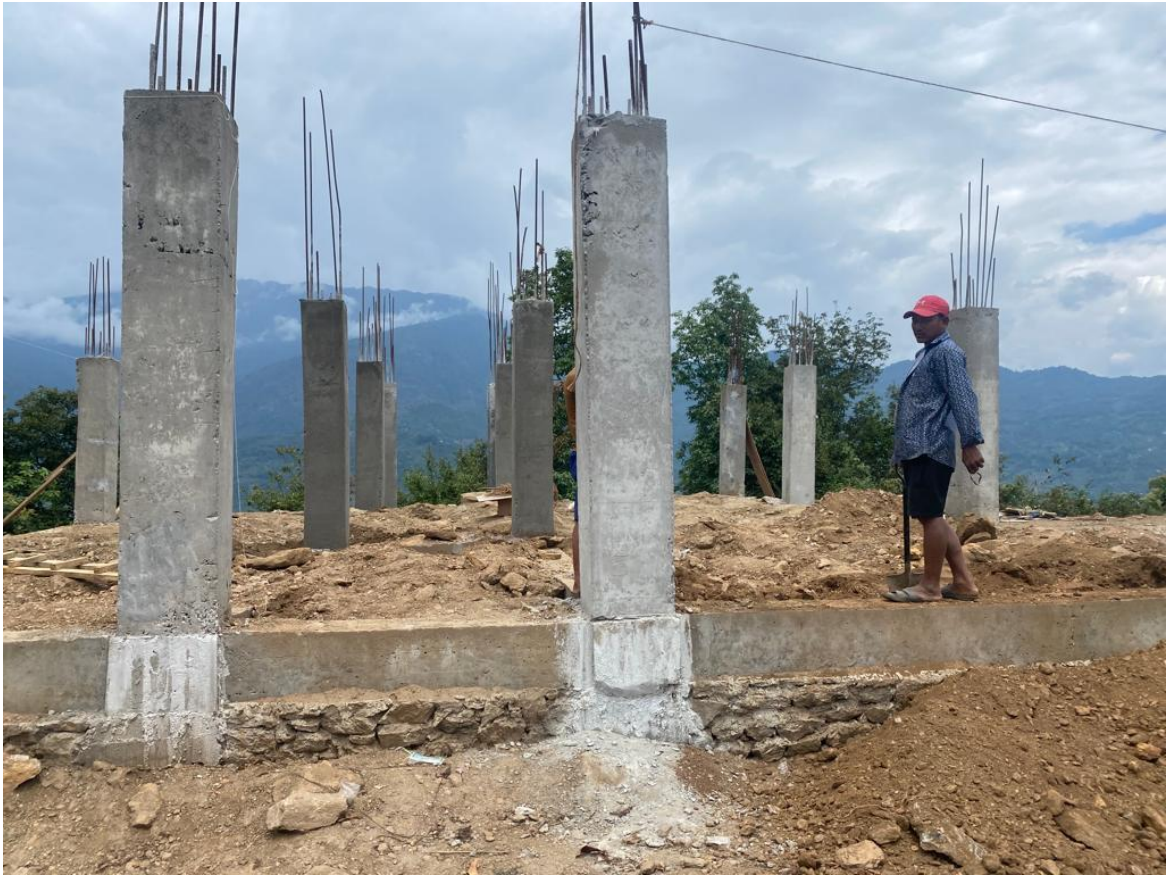
निर्माणधिन षडानन्द नगरपालिका १ नं वडा कार्यालय भवन
