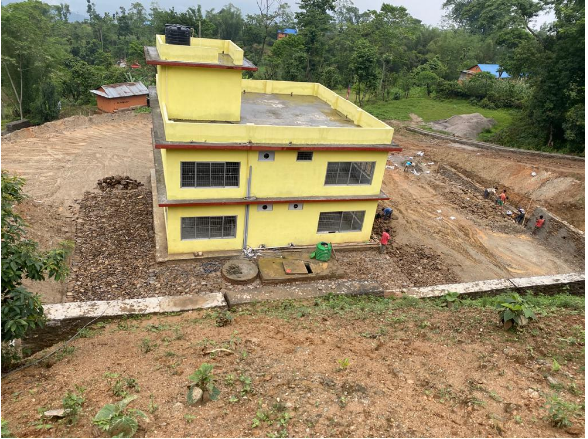
दिङ्ला बस पार्क भवन निर्माण सम्पन्न
