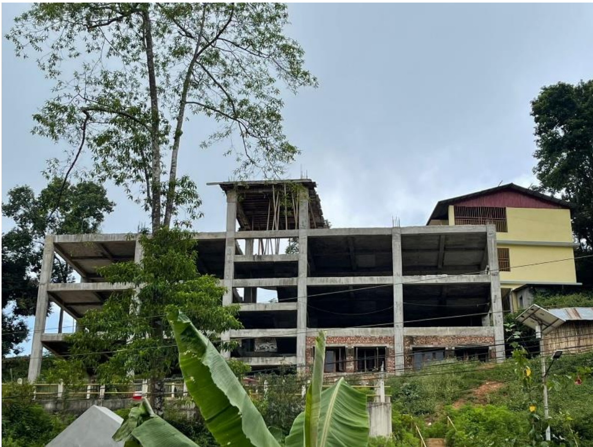
षडानन्द नगरपालिका केन्द्र दिङ्ला बजार स्थित षडानन्द मा.वि. भवन निर्माण
